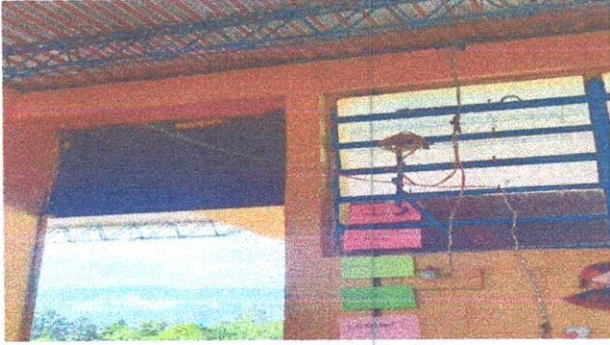
Foto 1: Reparación del sistema eléctrico de 6 aulas, dirección y cocina
