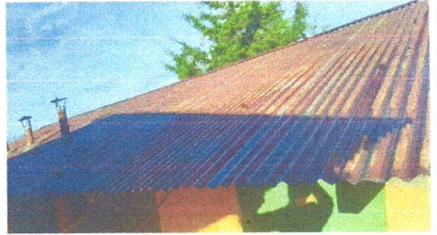
Foto 2: Sustitución techo de cocina
