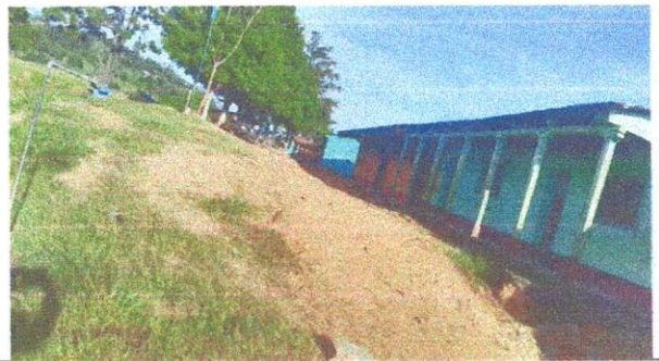
Foto 6: sustitución de red de agua potable
