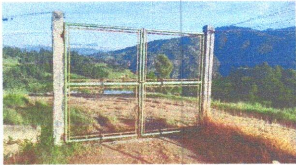
Foto 3: Sustitución de portón
